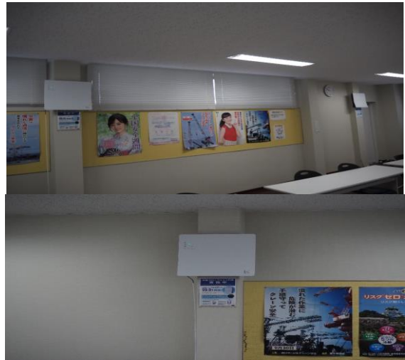
④ 換気 (外気取込 6箇所) (室内排気口6箇所)
